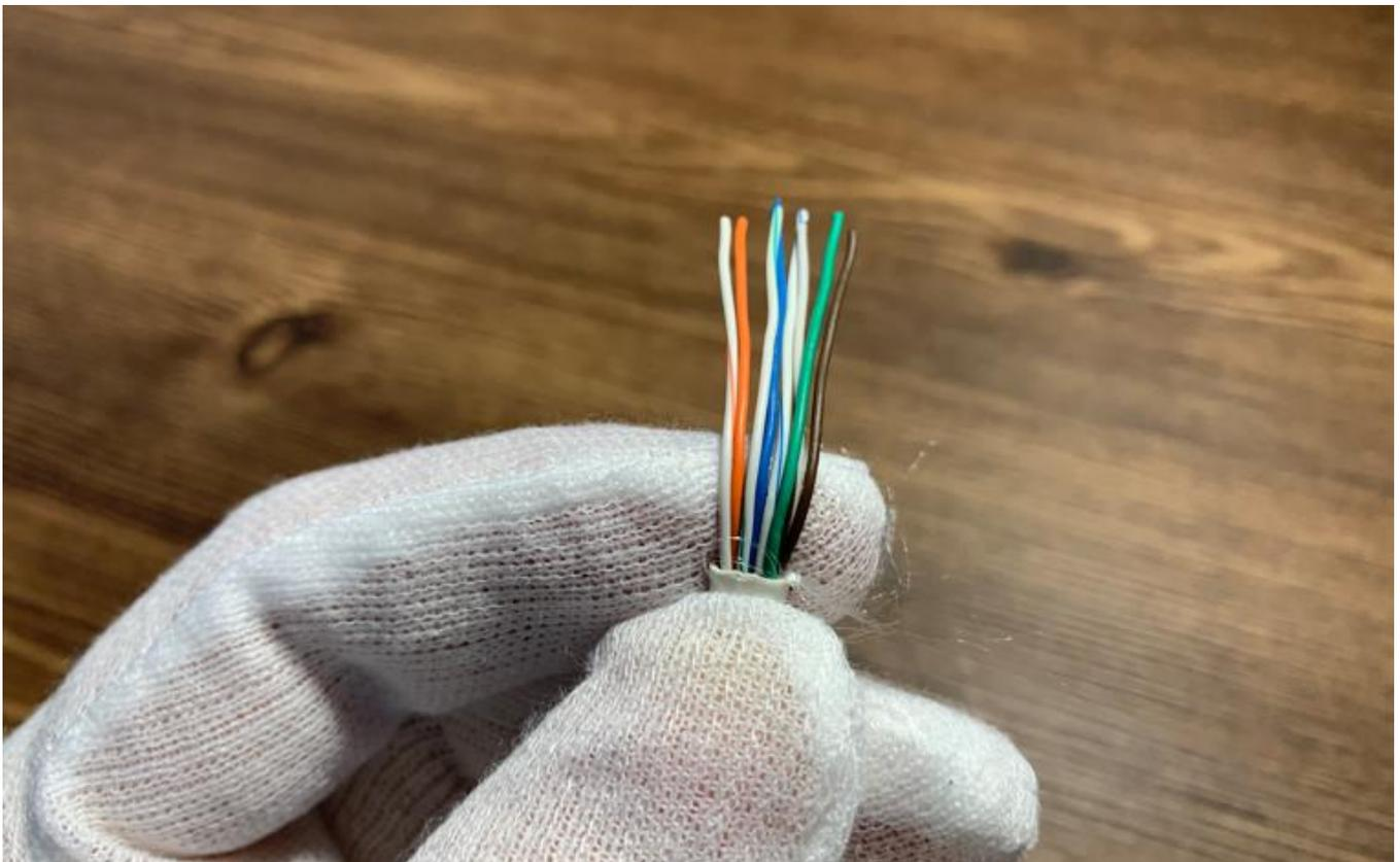
Примеряем провод к коннектору, чтобы определиться с нужной длиной проводников. Красными линиями на фото обозначены границы для оболочки и самих витых пар:
